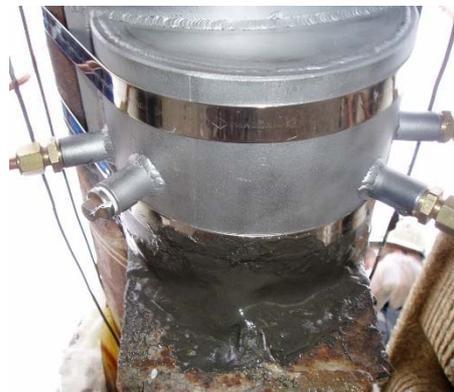
In einer Raffinerie wies eine Leitung aus Karbonstahl eine schwere Leckage auf, aus der mit hohem Druck (10 bar) Benzol ausströmte. Mit Hilfe einer Hilfskonstruktion, MM-metall oL-StahlKeramik und MM-metall SS-Stahl konnte die Undichtigkeit behoben werden. Hierbei kam neben dem üblichen Auftragsverfahren (Aufspachteln) auch das Injektionsverfahren zum Einsatz.
