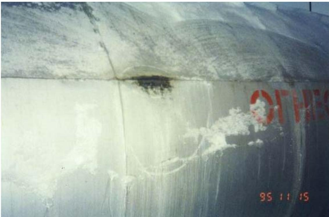
Reparatur eines Öl- / Gastanks unter arktischen Temperaturen. Die Instandsetzung wurde mit MM-metall UW und Härter UW3 in Russland durchgeführt.
